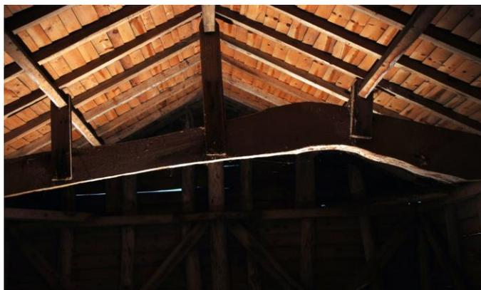
**Figura 17:** Travessa de uma asna em tronco aparelhado
