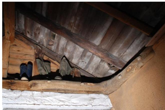
**Figura 19 –** Exemplo da utilização de um outro cunhal, desta feita numa união de canto. Note-se a fixação através de cavilhas em madeira
