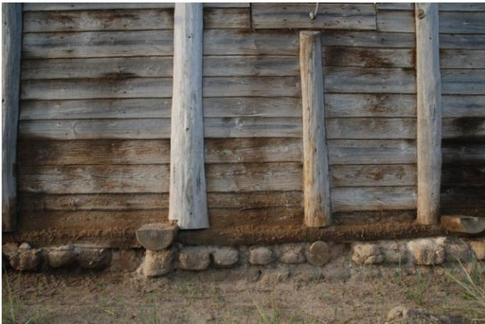
**Figura 7:** Exemplo de fundações em blocos de adobe; note-se que as mesmas são pouco expressivas, destinadas unicamente a “acamar” toda a estrutura
