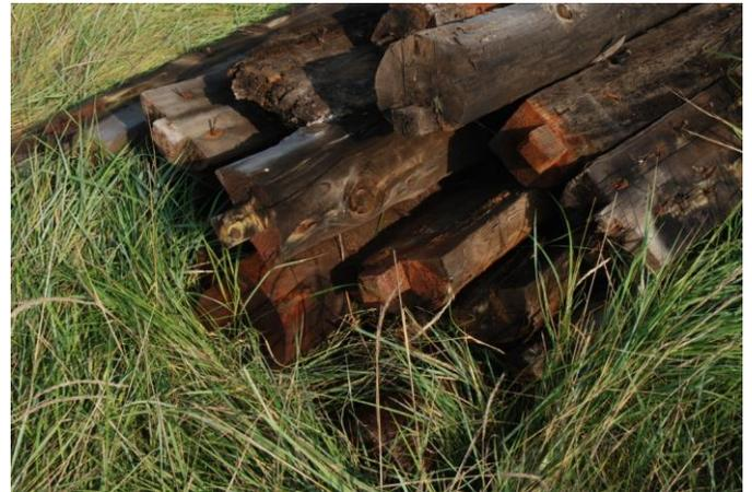
**Figura 11:** Conjunto de travessas sendo visíveis os malhetes a inserir nos entalhes
