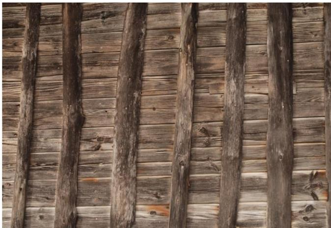
**Figura 14:** Outro exemplo do forro exterior, desta feita com pranchas verticais com menor espaçamento e aparelhamento mais rudimentar
