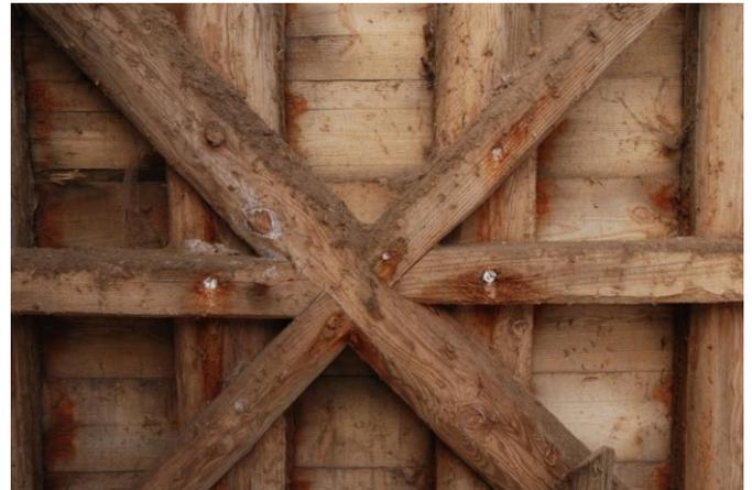
**Figura 15:** Pormenor dos entalhamentos do sistema “em tesoura”
