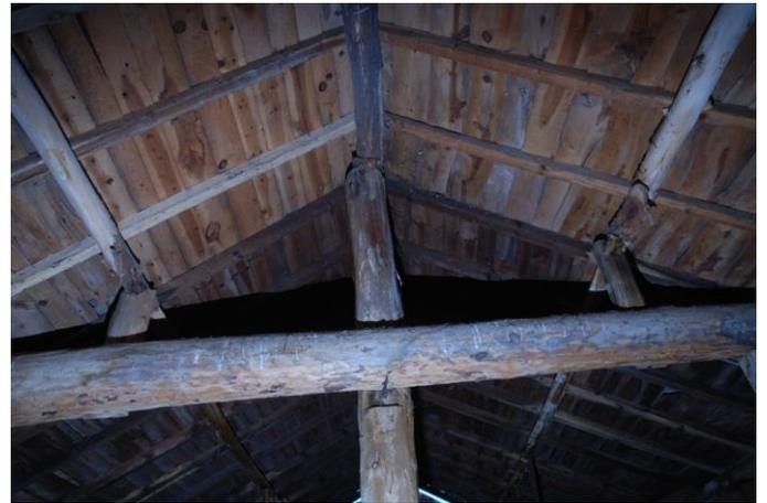
**Figura 8:** Prumo (pendural) de suporte da linha da asna construído a partir de um tronco, desde a cobertura (cumeira) ao solo. Note-se o entalhe tosco no mesmo destinado a receber a linha da asna
