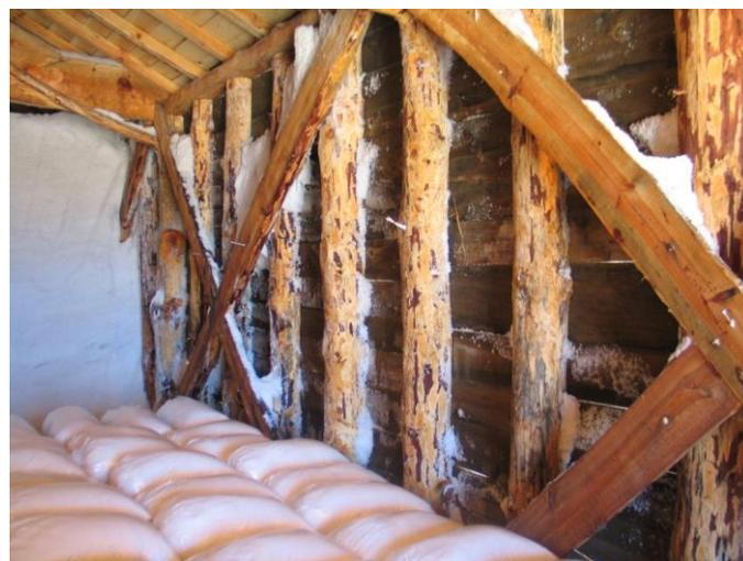
**Figura 5:** Armazém em utilização. Note-se os depósitos de sal na madeira resultantes do seu anterior preenchimento
