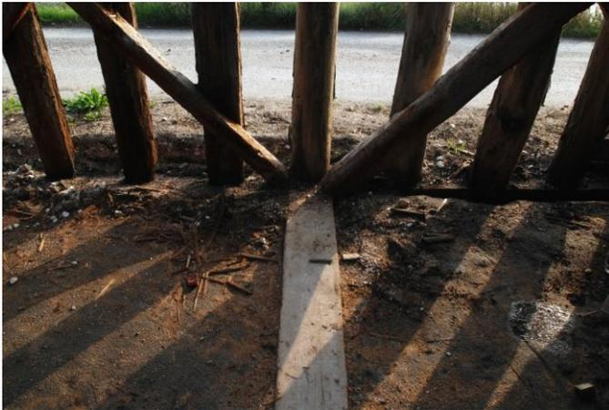
**Figura 9:** Exemplo de travessa enterrada no solo
