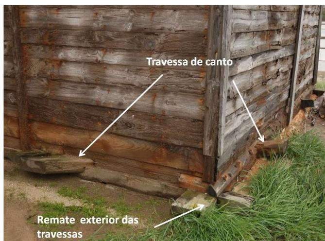
**Figura 21:** Remate das várias travessas de assentamento
