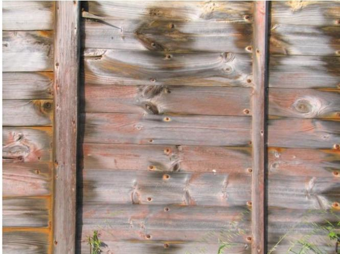
**Figura 13:** Detalhe do forro exterior; note-se as pranchas verticais de reforço
