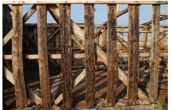
**Figura 12:** Travessas verticais, com o lado aparelhado virado para a face exterior – que irá receber a madeira de forro -, estando emalhetadas e fixadas no topo e na base
